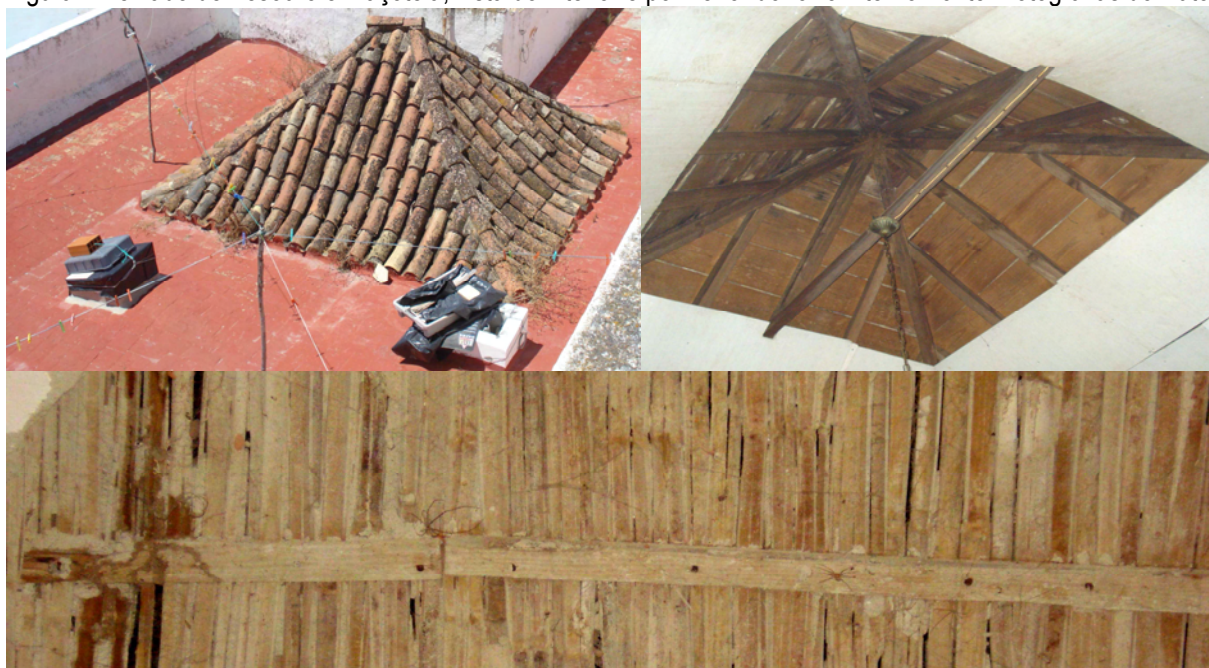
Figura 7-Telhado de Tesouro em açoteia, vista do interior e pormenor do forro interno.Fonte: Fotografias do Autor.
